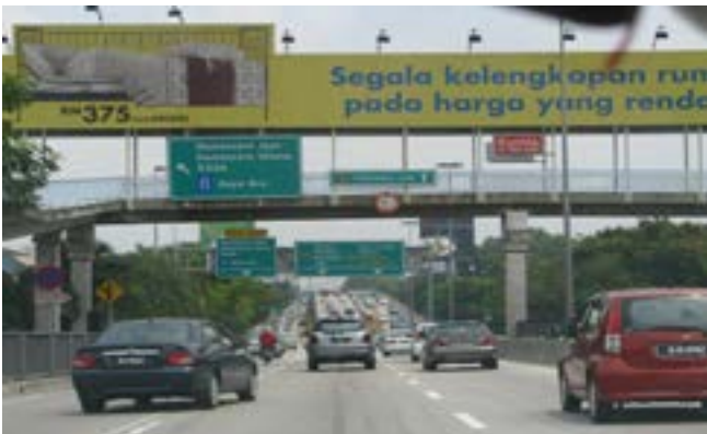
Pemasangan papan iklan pada jejantas yang disekalikan dengan papan tanda lalu lintas boleh menimbulkan kekeliruan kepada pengguna jalan raya.
