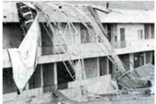
Papan iklan bumbung yang telah rebah akibat angin kencang semasa ribut hujan batu di Petaling Jaya, 2000.
