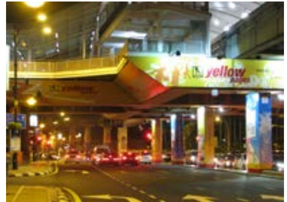
Iklan Pillar/Column Wrap Pada LRT di kawasan Bukit Bintang ini adalah menarik dan mampu menyumbang kepada keceriaan bandar. Walau bagaimanapun pencahayaannya pada waktu malam hendaklah tidak menyilau dan menjejaskan keberkesanan peralatan kawalan lalu lintas.
